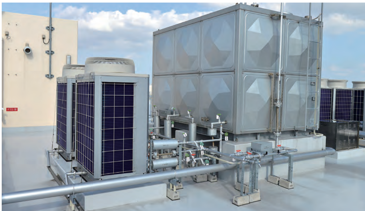
業務用エコキュート（加熱能力40kW×2台）・貯湯槽（12m×1基）
