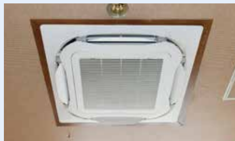
個室では埋め込み式の空調室内機を導入。ガスから電気空調になったことで、各個室ごとの運転や温度管理が可能に。
