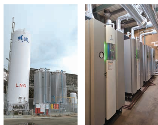
敷地奥に設置されたサテライト設備 最新の高效率ボイラに更新
